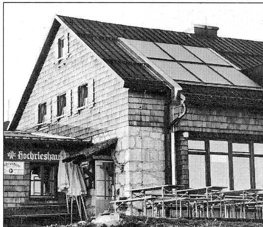
Vielen Besuchern sind sie vielleicht noch gar nicht aufgefallen — die energiespendenden Solarkollektoren auf dem Dach des Hochries-Gipfelhauses. Foto: Franz Knarr
